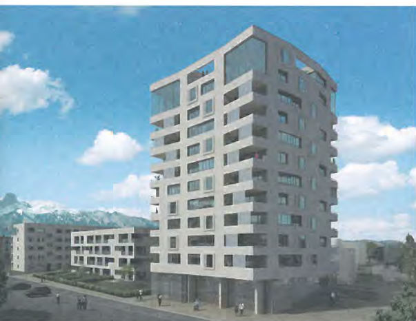
^16_Wohnüberbauung Selve, im Bau.
