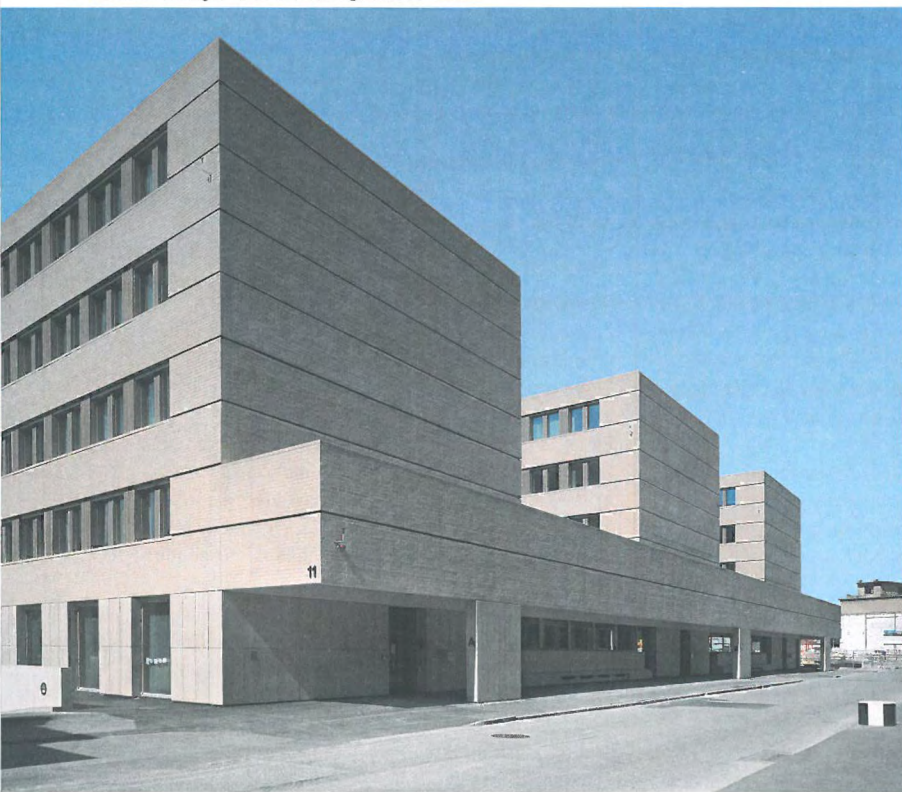
∨14_Verwaltungs- und Gerichtsgebäude Selve.
